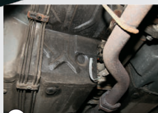
9 Hier wurden die Schweißverbindungen am Kardantunnel bereits gegen Rostbefall behandelt
