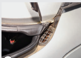
12 Ist dieser Abfluss an der C-Säule verstopft, kann Wasser in den Kofferraum eindringen
